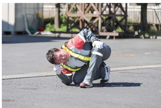
昼間作業（漏水位置特定）
