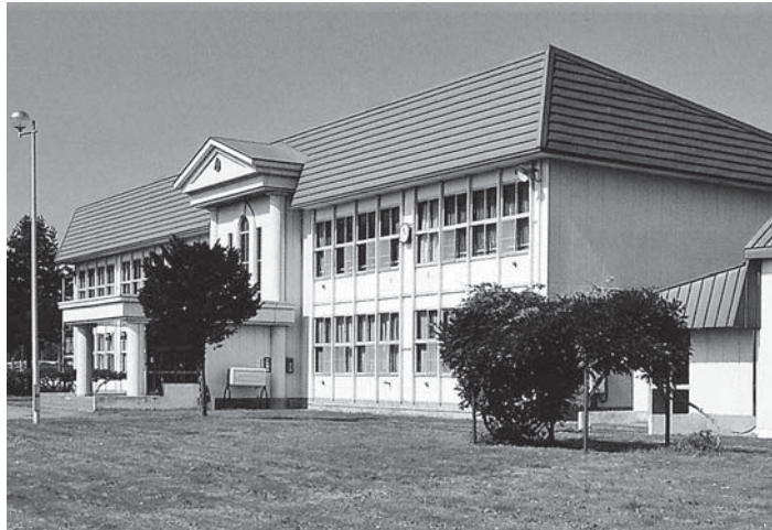
新たな利活用が検討されている旧高島中学校校舎
